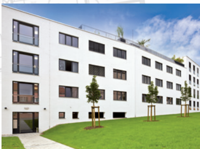
Bilder: Regnauer Fertigbau
